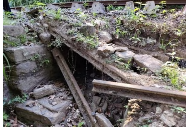
படம் 5b: தளம் எண் 231 புகையிரத பாதைக்குக் கீழே உள்ள பருவகால நீரோடை மற்றும் சேதமடைந்த சிறுபாலம்
