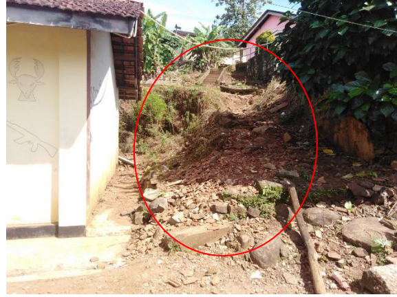
படம் 4 g : கேடட் அறைக்கு அருகில் சரிவு தோல்வி
