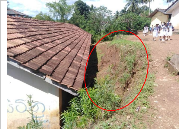
රූපය 5e: 7 ශ්‍රේණියේ තනි මහල් ගොඩනැගිල්ල පිටුපස අස්ථායී බෑවුම නාය යාම
