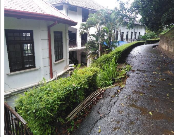
படம் 4 e : ஆசிரியரின் சுகாதார வசதி மற்றும் வீட்டு அறிவியல் ஆய்வகத்தின் பின்னால் தோல்வியுற்ற சாலை மற்றும் சாய்வுப் பகுதி (L5)
